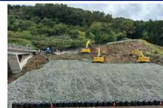
【土砂撤去・掘削作業】
