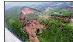
長崎県北西部の地すべり
