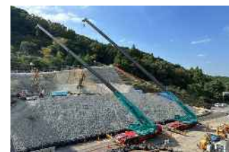
【切土補強土工(鉄筋挿入工)】
