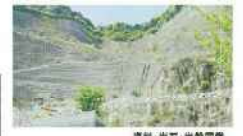
凝結・粘着・岩盤間隙 水分を含むと強度が落ちるシラス台地
